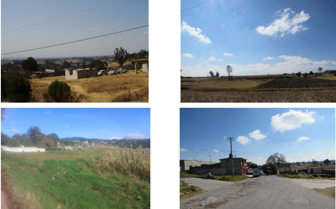
Imagen 3 Fotografías de la estructura de la vivienda de la UGASCT.
